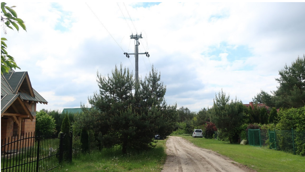
Ryc. 12. Linia elektroenergetyczna średniego napięcia wzdłuż ul. Zachodniej
