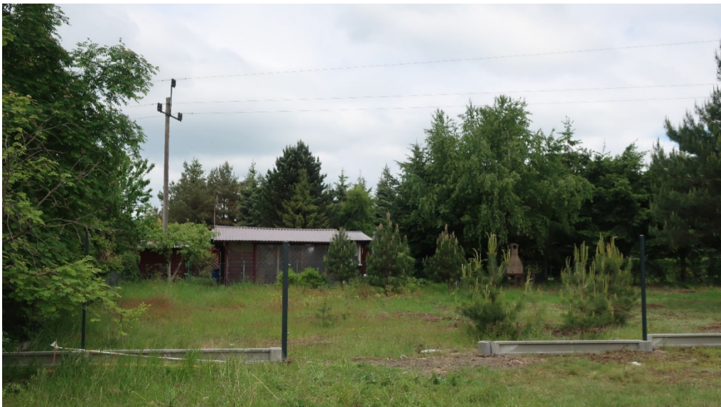
Ryc. 11. Linia elektroenergetyczna średniego napięcia przy ul. Południowej
