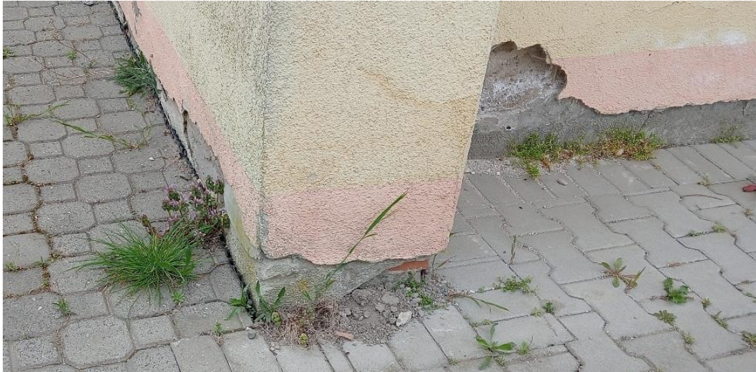
Ryc. 19 Budynek OSP w Mochach
