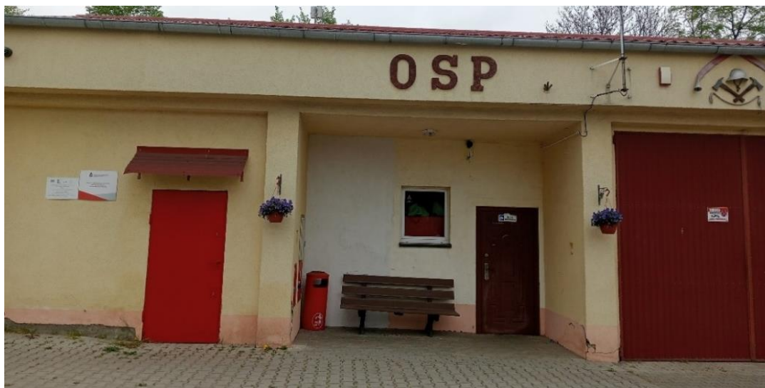
Ryc. 18 Budynek OSP w Mochach
