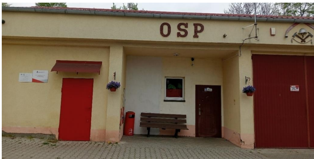
Ryc. 18 Budynek OSP w Mochach
